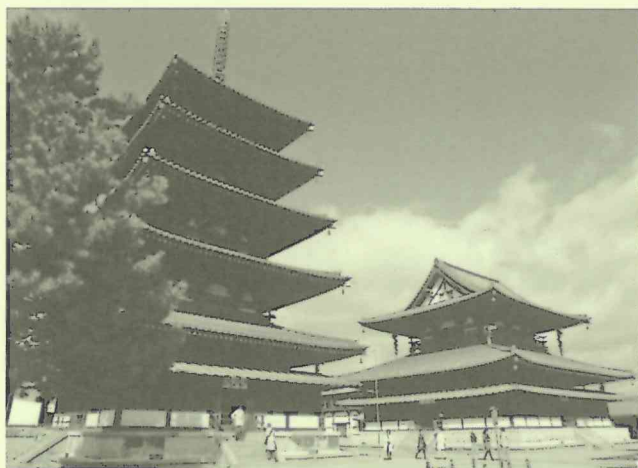
世界最古の木造建築物、法隆寺の金堂・五重塔(著者撮影)
